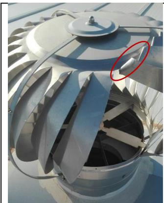
Los álabes parten directamente del plato superior sin remaches. Su diseño puede provocar la rotura de dichos álabes por la acción del viento, provocando una incorrecta extracción, y entrada de agua.
